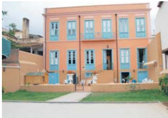
EL EDIFICIO DE LA ONG, SITUADO EN LA CALLE DE TOMÁS ZEROLO, SE DIVIDIRÁ EN DOS UNIDADES DE
