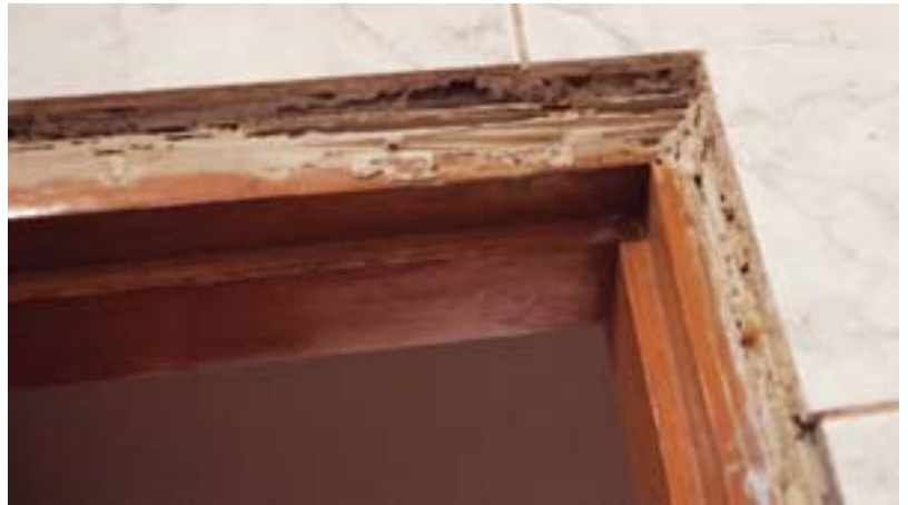
Marco de la puerta de la casa de unos vecinos de Tacoronte, afectados por las termitas. | CARSTEN W. LAURITSEN
